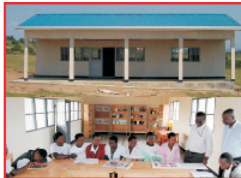
Le premier bâtiment du centre qui sert de bibliothèque
