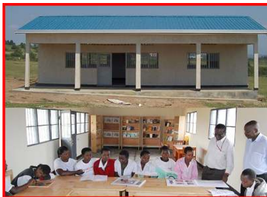
El primer edificio está construido y está en uso: la biblioteca
